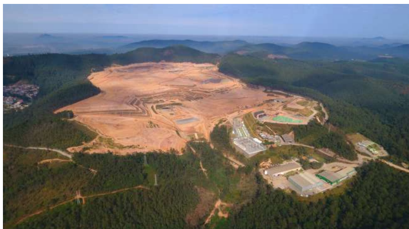
[Vista aérea da UVS Essencis Caieiras, SP, 2018 - Foto: Comunicação Essencis Caieiras]
